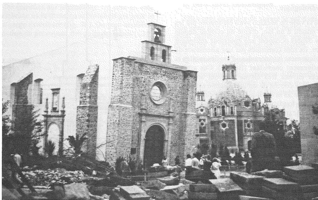
Fig. 43. — Tassement différentiel d'une église avant achèvement des travaux.
