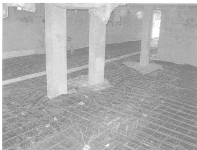
FIG. 12 Treillis soudé avant coulage du béton de dallage. Girder before casting of pavement.
