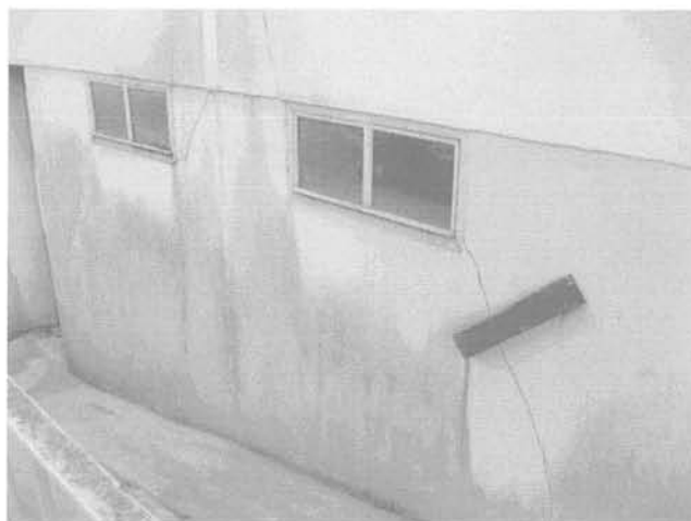
FIG. 4 Vue sur fissure oblique (rampe du sous-sol bâtiment E) avec capot de protection de l'instrumentation. View of disorder and instrumentation.
