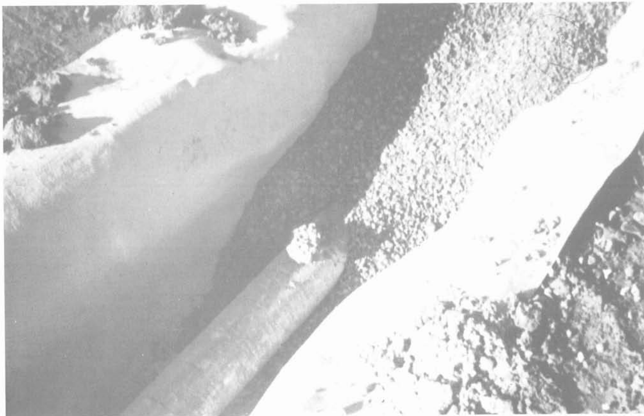
Les géotextiles employés comme filtre ont considérablement amélioré les conditions de réalisation des ouvrages de drainage.
