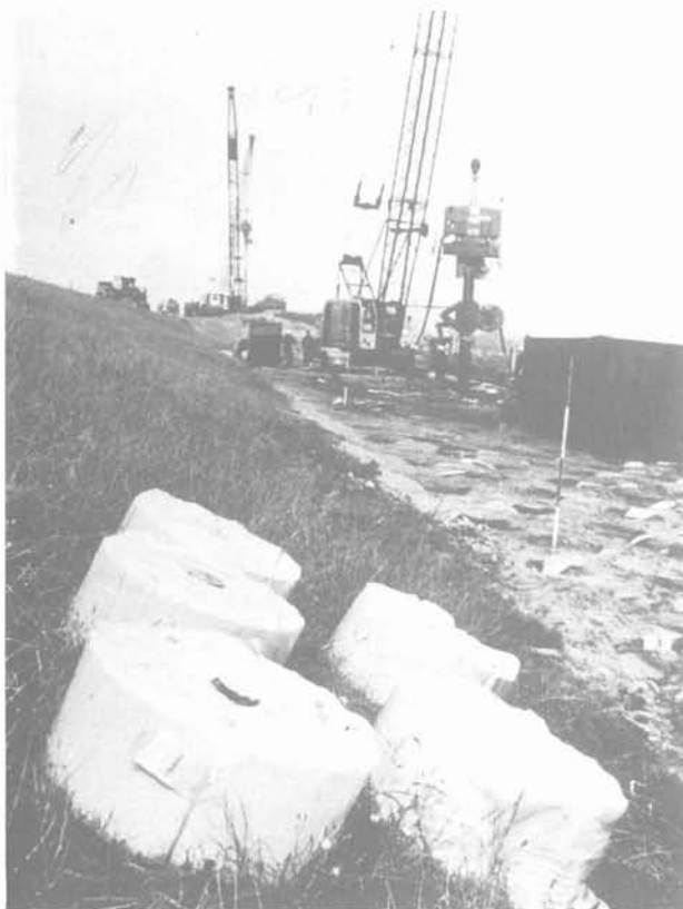
Drainage vertical avec géotextile.
