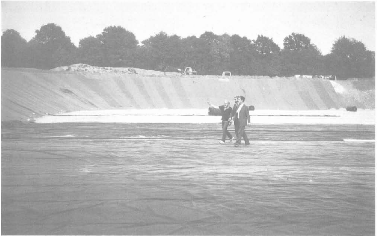
Les géomembranes et les géotextiles constituent, ensemble, des dispositifs minces d'étanchéité pour toutes sortes de bassins et d'ouvrages.
