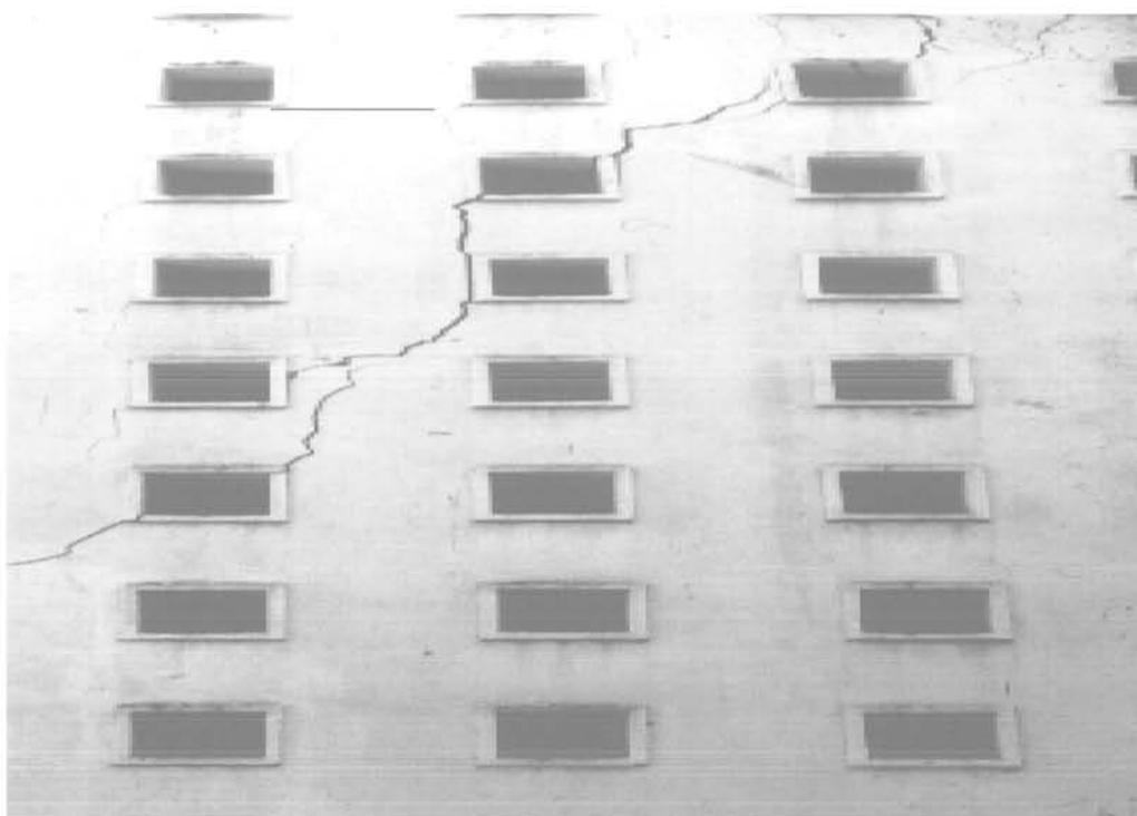
FIG. 1 Fissuration au niveau de la cage d'escalier de l'hôpital de Sidi Chahmi.
