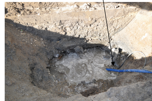
Système de pompage
