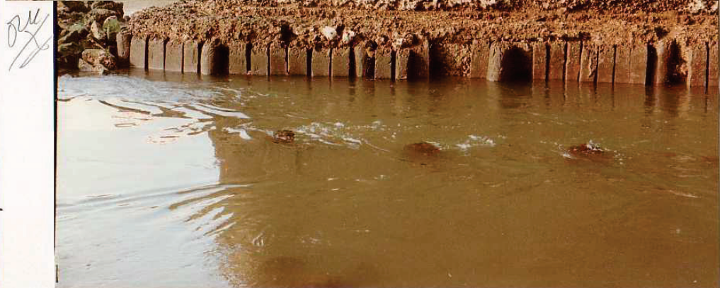
Ligne de Morcenx à Bagnères: Pont de Maubourquet sur l'Echez: les enroche- ments masquaient une cavité s'étendant sur le 1/3 de la surface d'assise Travaux conservatoires: 1983 Confortement: 1984
