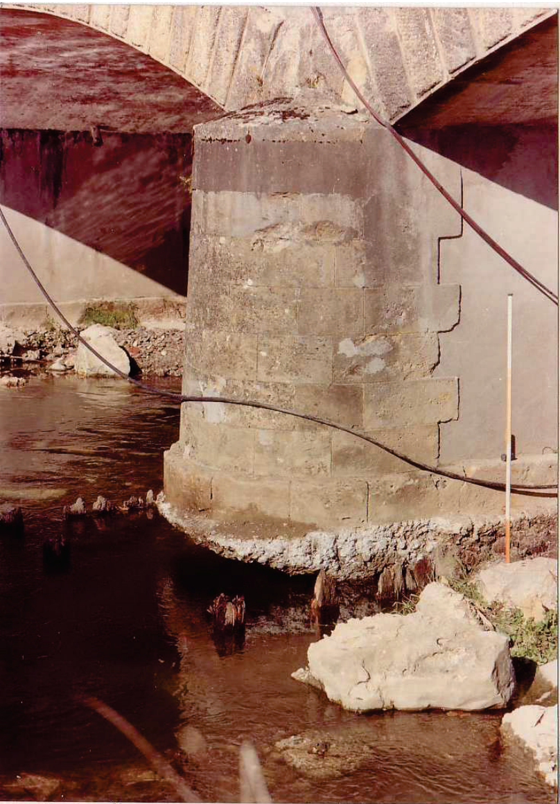
Ligne de Morcenx à Bagnères: Pont de Maubourquet sur l'Echez: les enroche- ments masquaient une cavité s'étendant sur le 1/3 de la surface d'assise Travaux conservatoires: 1983 Confortement: 1984
