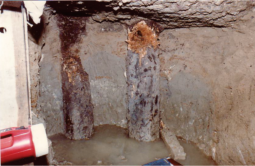
Pourrissement des pieux bois
