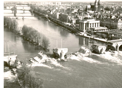
Pont Wilson (Tours)
