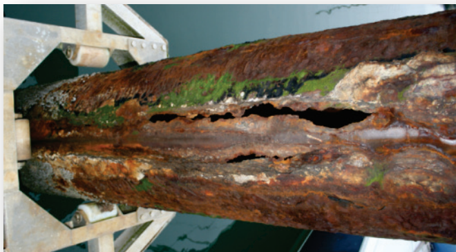
Pieux métalliques du ponton du port de Tréguier (22)
