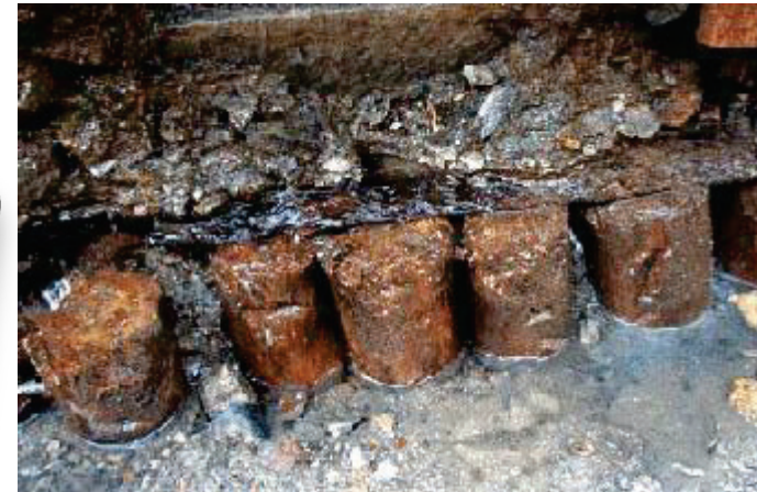
Fondations romaines en chêne d'une Insula, Avenches, Suisse, 1 er s apr. J-C
