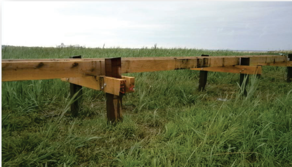
(Source: exemples d'un chantier de passerelle bois , mai 2013)
