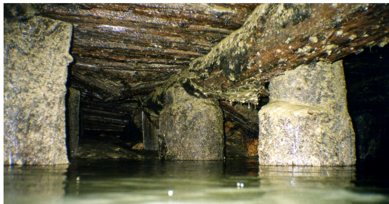
Figure 9. Exemple de détérioration du platelage en hêtre sous les quais du Grand Port Maritime de Rouen
